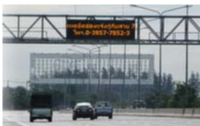
ป้าย VMS
