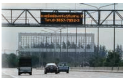
ป้าย VMS
