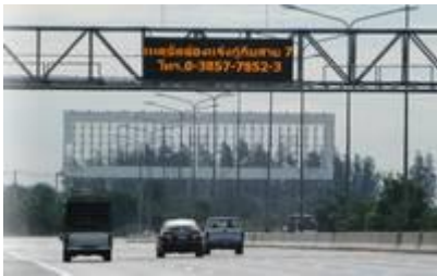
ป้าย VMS
