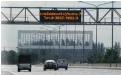
ป้าย VMS
