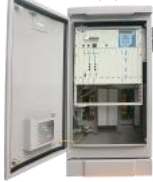
ตู้ควบคุมสัญญาณไฟจราจร
