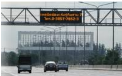
ป้าย VMS
