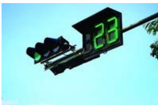
เครื่องนับเวลาก่อนเปลี่ยนสัญญาณไฟจราจร
