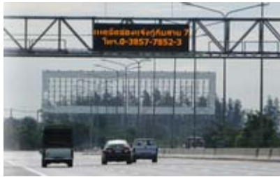
ป้าย VMS
