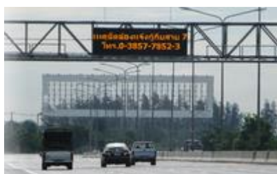
ป้าย VMS
